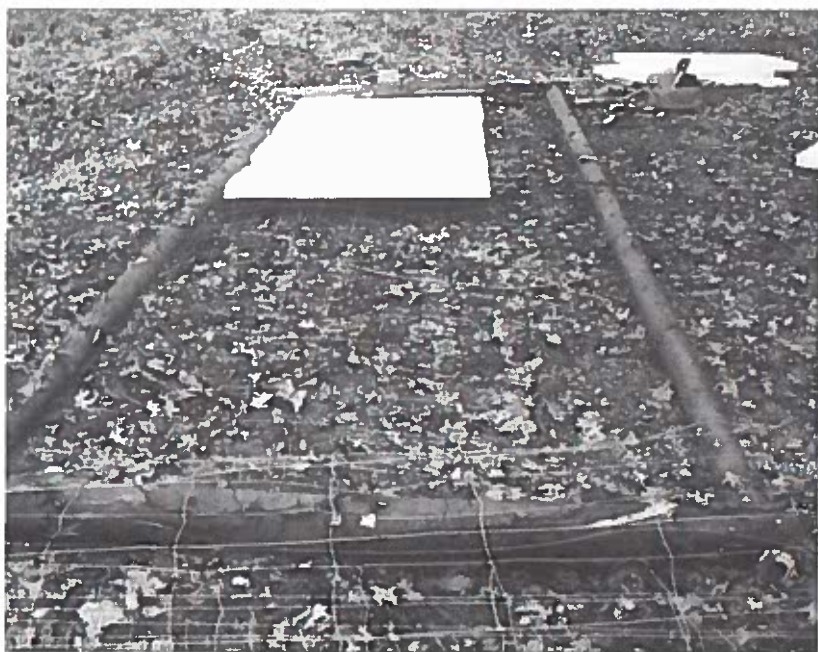
Fig. 22. Først laves en ramme af lægter og vildthejn fastgøres til den ene side.
