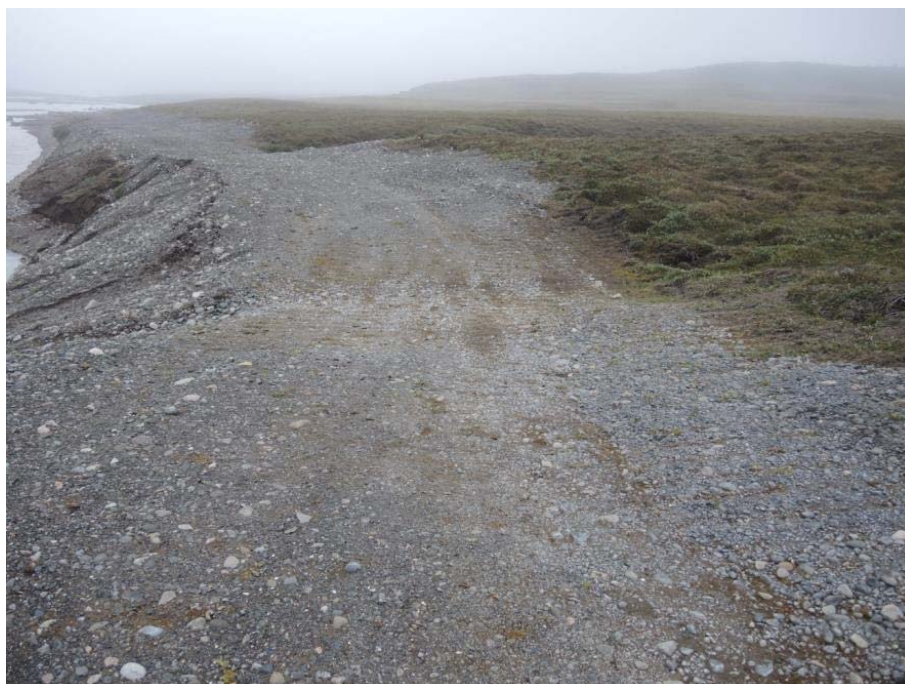
Figur 22. Samme sted som Figur 21, 4. august 2015. Sporet er blevet planeret, skrænterne jævnet ud og der er lagt grus på.
