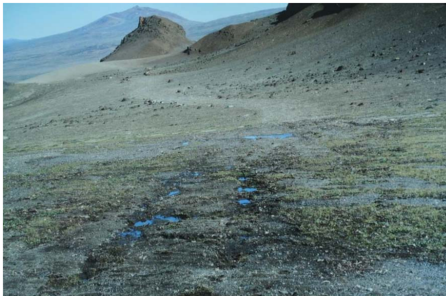
Figur 20. Skade nr. 4, 15. juli 1998. Hullet er fyldt op med grus og overfladen planeret.
