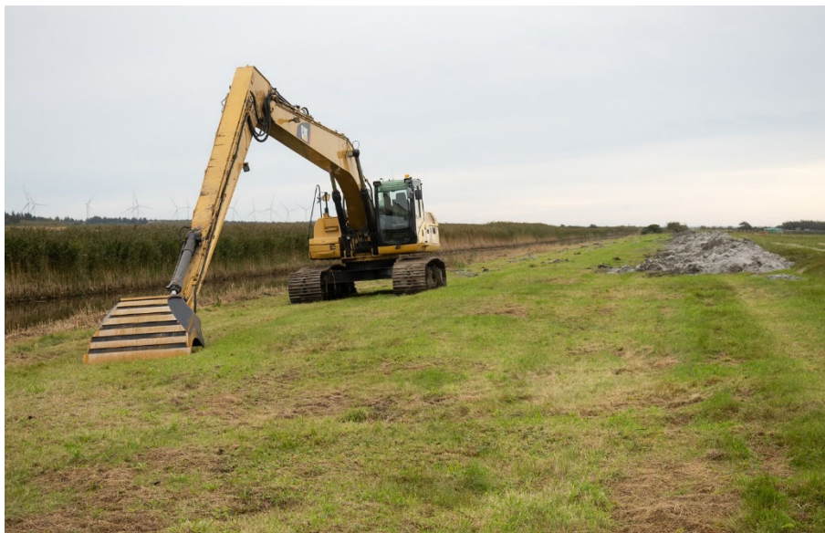
Foto 7. Østre Landkanal blev oprenset og uddybet i oktober. Det oprensede jord/sand blev lagt ud langs Østre Landkanal Diget.
