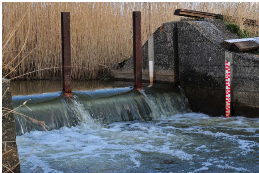
Figur 7. Mommer, 5. april 2012. Stemmebrædderne er fjernet fra slusen, og der er frit udløb af vandet fra Tømmerby Fjord. Foto: Henrik Haaning Nielsen, ornit.dk.
