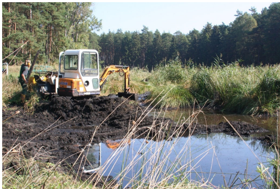
Figur 3.18. Bortgravning af stærkt nedbrudt tørv i en minerotrof mose før den vådlægges igen. Lokaltet: Lehtsee-Niederung i delstaten Brandenburg, nordøst Tyskland (Zak et al. 2017).
