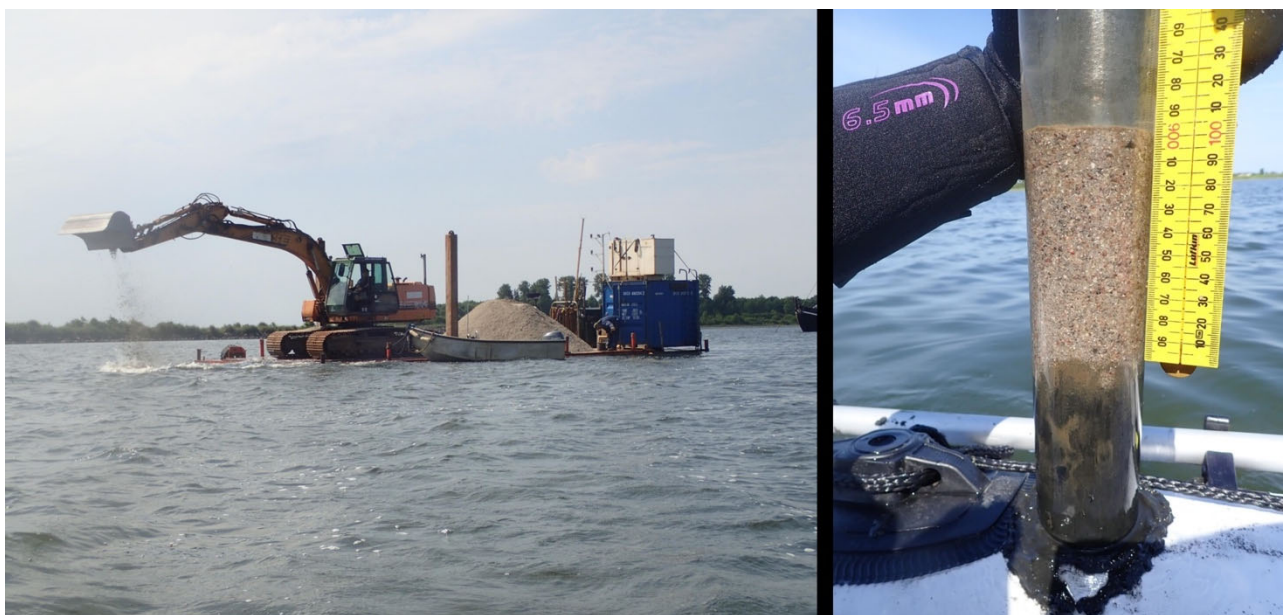
Billede 3.4.1. Til venstre udlægningen af sandmembranen ved Dørholm Bugt i Odense Fjord udført af Odense Havn. Sandet blev lastet ombord på en stor flydepram og lagt ud med en GPS-styret gravko. Til højre er en sedimentkerne, som viser, at den aftalte sandlagstykkelse på ca. 10 cm blev udlagt.
