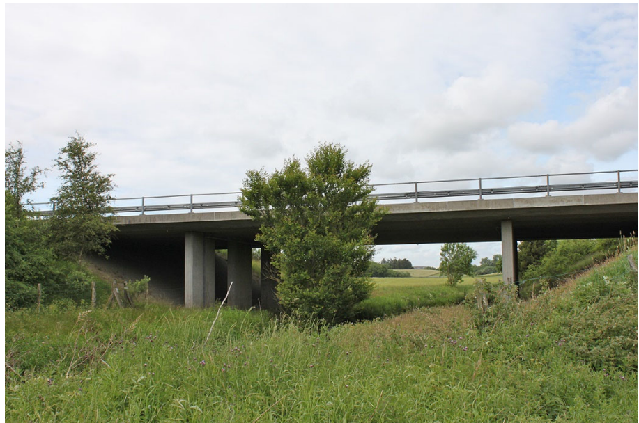
Figur B1.11. Underføringen ved Sæby Å er udformet som en landskabsbro. Vildthejn ved foden af vejdæmningen medfører at passagen er forholdsvis lang.
