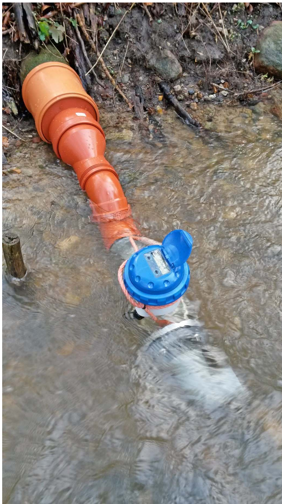
Figur 32. Måling med elektromagnetisk flowmåler 50 mm. Drænudløb: 200 mm betonrør.
